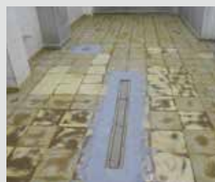
Reforço de grelhas
