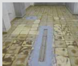
Reforço de grelhas
