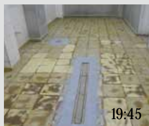
Reforço de grelhas
