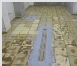
Reforço de grelhas
